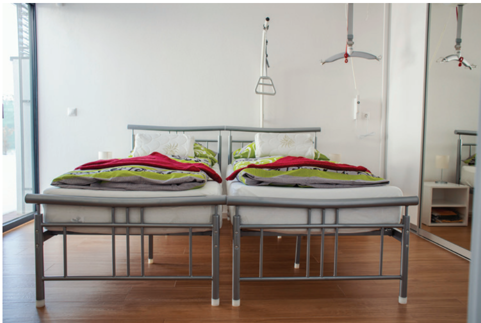
Bezproblémový presun na posteľ zabezpečuje stropné zdvíhacie zariadenie (Fotil: Pavol Kulkovský)
